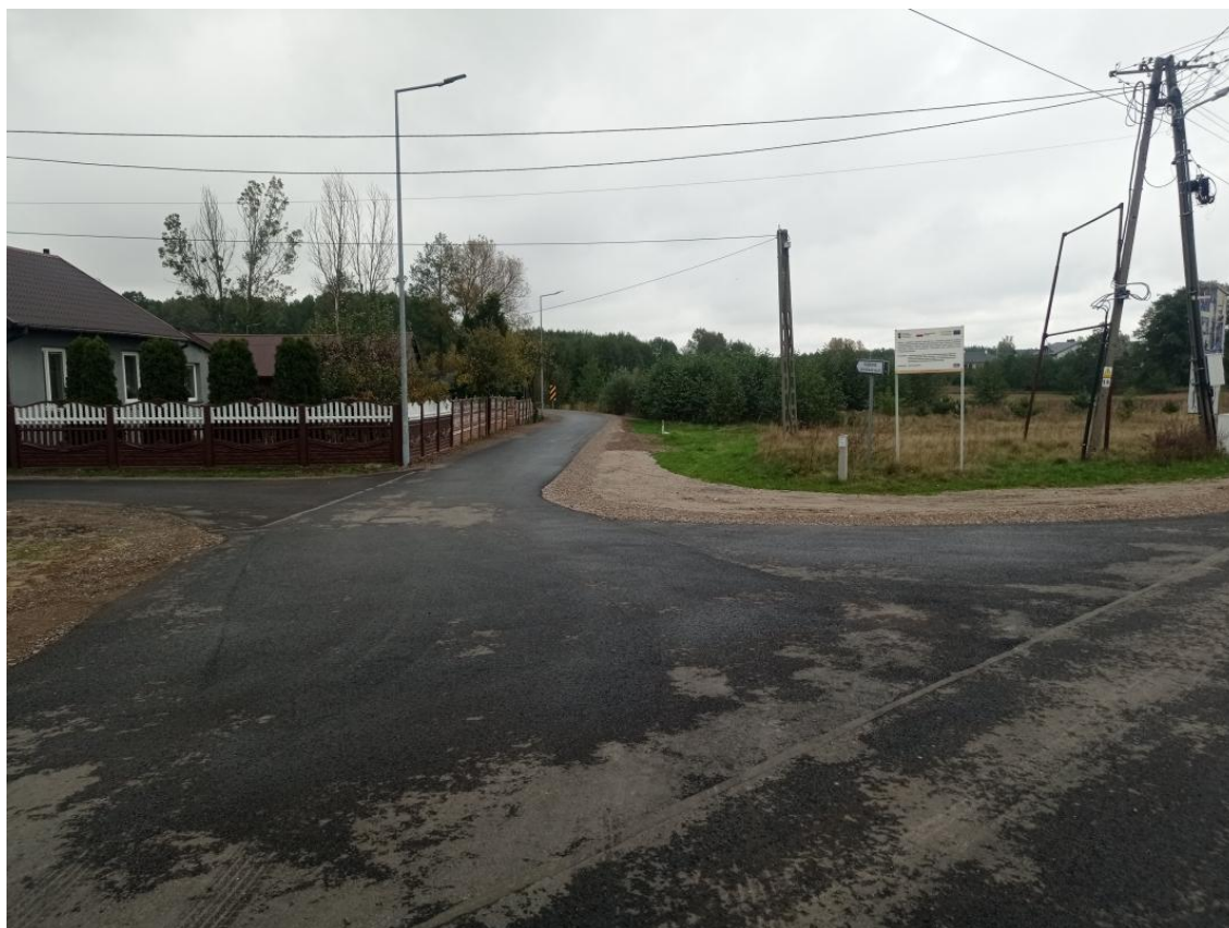
Zdjęcie 16.1.10. Modernizacja drogi w miejscowości Olszowiec.
