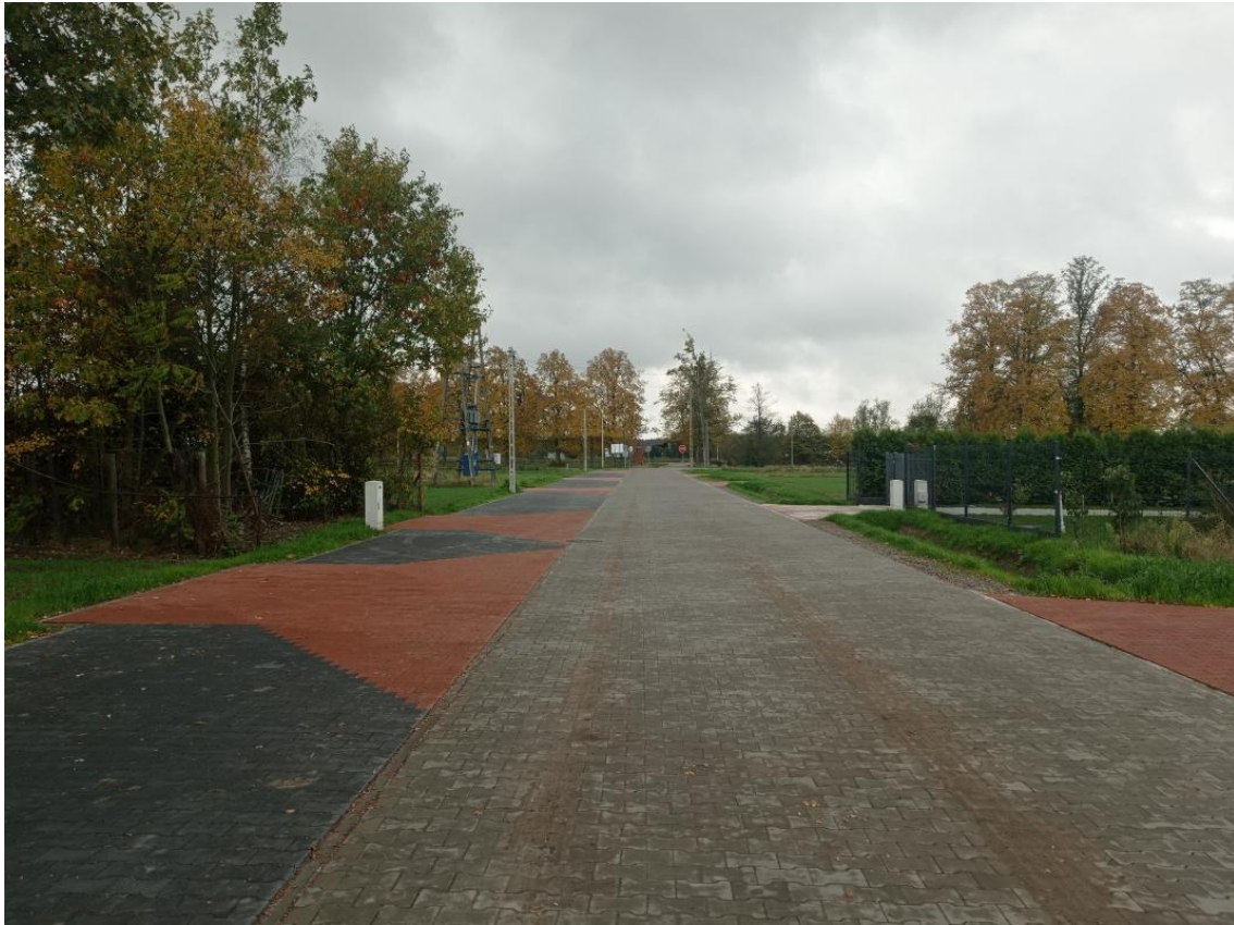
Zdjęcie 16.1.9. Rozbudowa drogi w miejscowości Glinnik.
